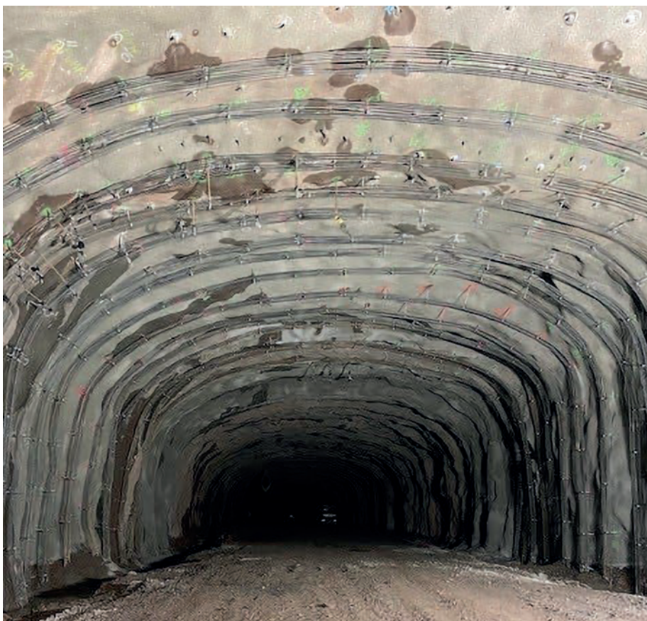
Figur 22. Serie av installerad armering för sprutbetongbågar (Dahlberg, 2024).
