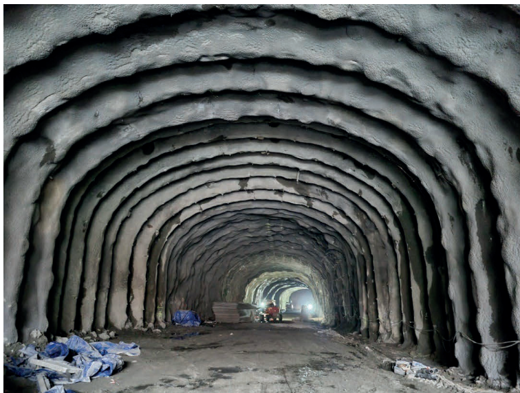
Figur 34. Foto av sprutbetongbågar i Almedal, 2024-02-29.
