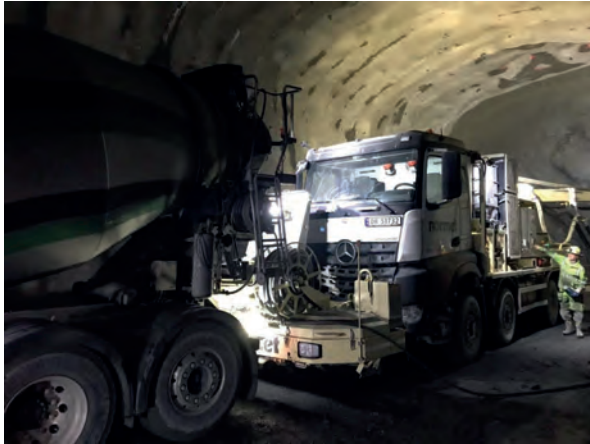
Figur 6. Betongblandarbil som överför stålfibersprutbetong till sprutrigg. Från Oustampasidis (2019).
