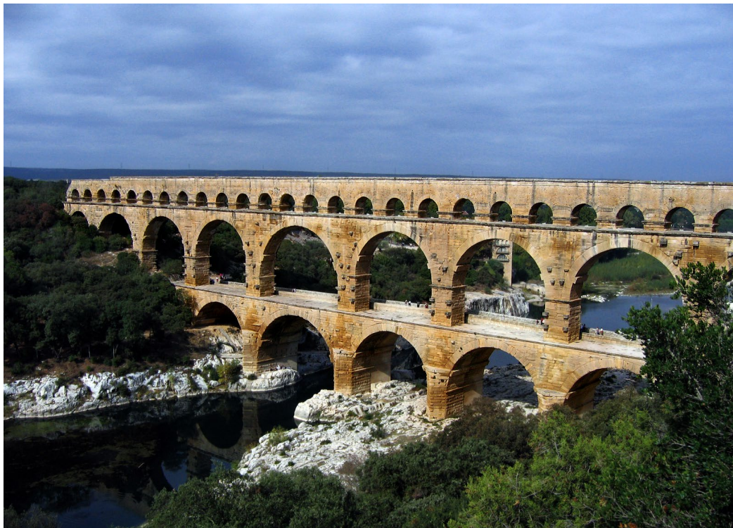
Akvedukt Pont du Gard med tryckta bågar i dåtida romerska Galileen, nutida södra Frankrike) (CC-BY-SA 2.0 Pont du Gard Oct 2007 - Akvedukt – Wikipedia )
