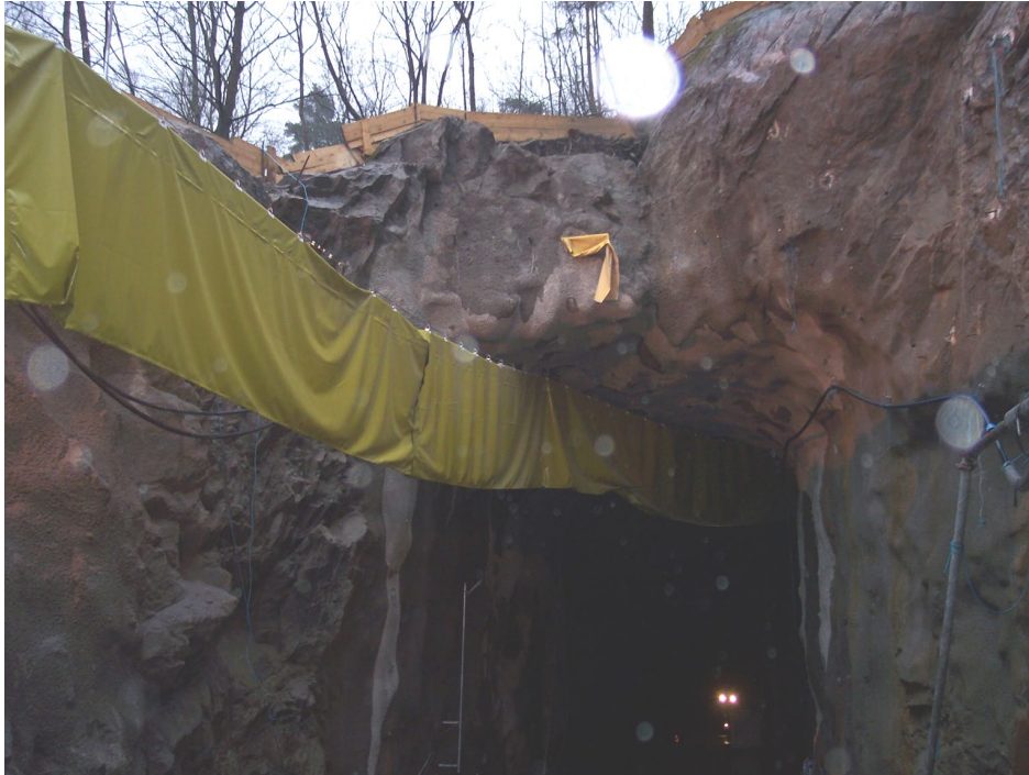
Tunnelportal med bärande valv (Foto: Fredrik Johansson)
