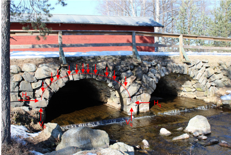
Gammal stenbro i Dalarna med tryckta valv (Foto: Johan Spross)
