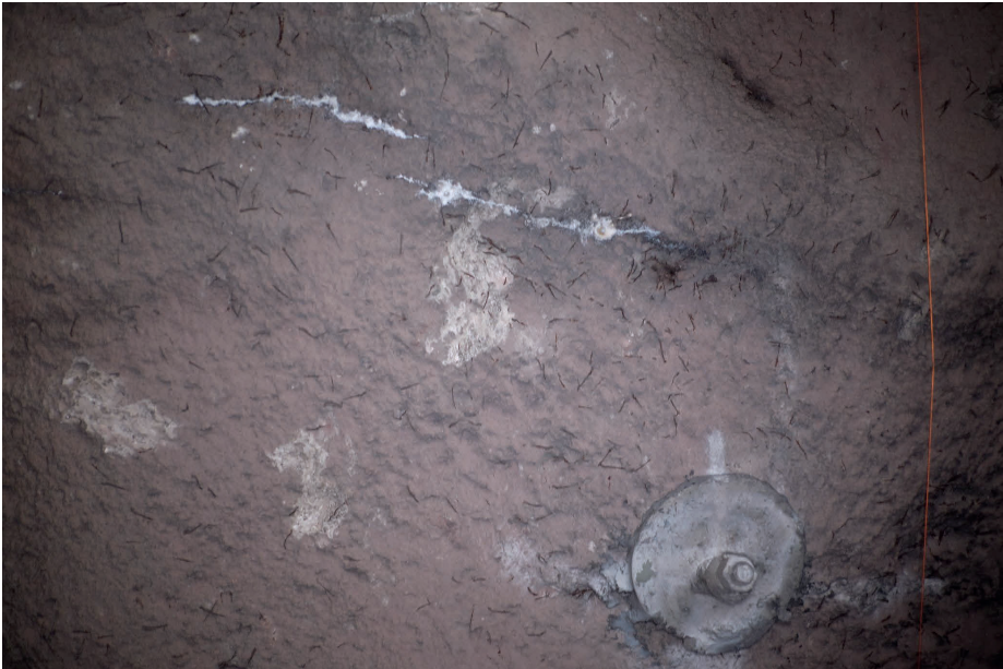
Figur 47: Foto taget med systemkamera. Naturlig spricka (bild 5393).
