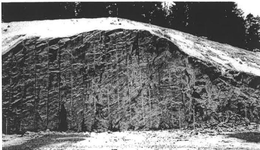
Figur 9: Foto av bergväggen längs sträckorna 3-0 (vänster till höger) efter sprängning.
