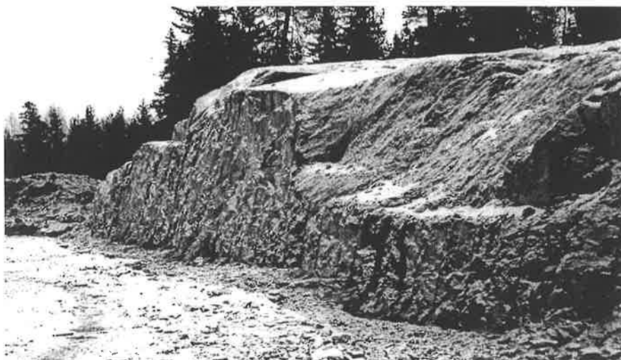
Figur 10: Foto av väggen längs sträckorna 13-9 (vänster till höger) efter sprängning
