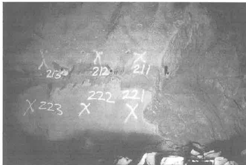
Figur 4.14: Återstående sprutbetong samt krater vid försöksområde 2. Remaining shotcrete and crater formed after test 2.
