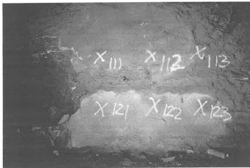
Figur 4.12: Återstående sprutbetong samt krater vid försöksområde 1. Remaining shotcrete and crater formed after test 1.
