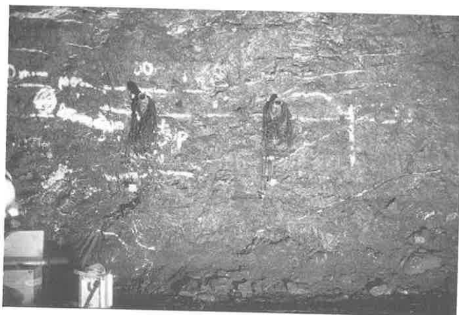
Figur 4.3: Försöksområde 2 före betongsprutning. Test site 2 prior to shotcreting.
