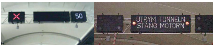
Figur 16. Exempel på MCS-skyltar (Motorway Control System) och Tunnelinformationsskylt mellan MCS skyltarna.
