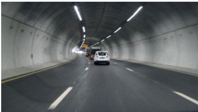
Figur 7. Exempel på tunnel med betongelement längs hela profilen. Lørentunnelen, Norge.
