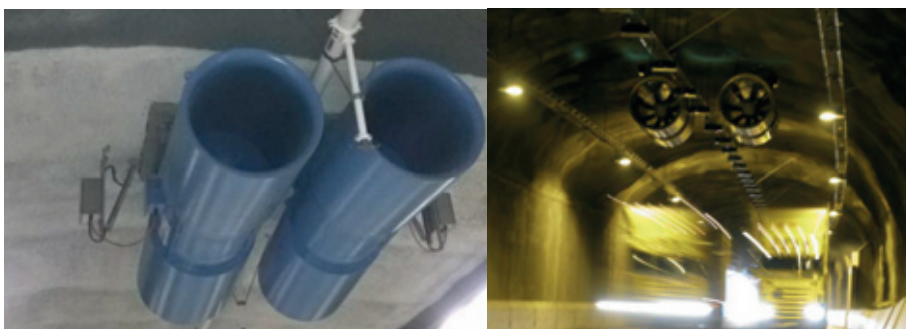
Figur 18. Impulsfläktar i tunneltak, Norra länken t.v. och Norrortsleden till höger.
