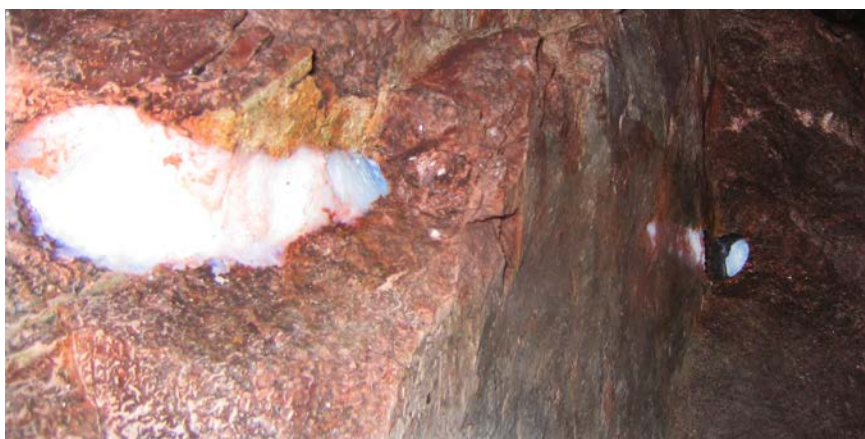
Figur 3-8. En bra silica sol plugg i ett borrhål. Bild från Hallandsås.
