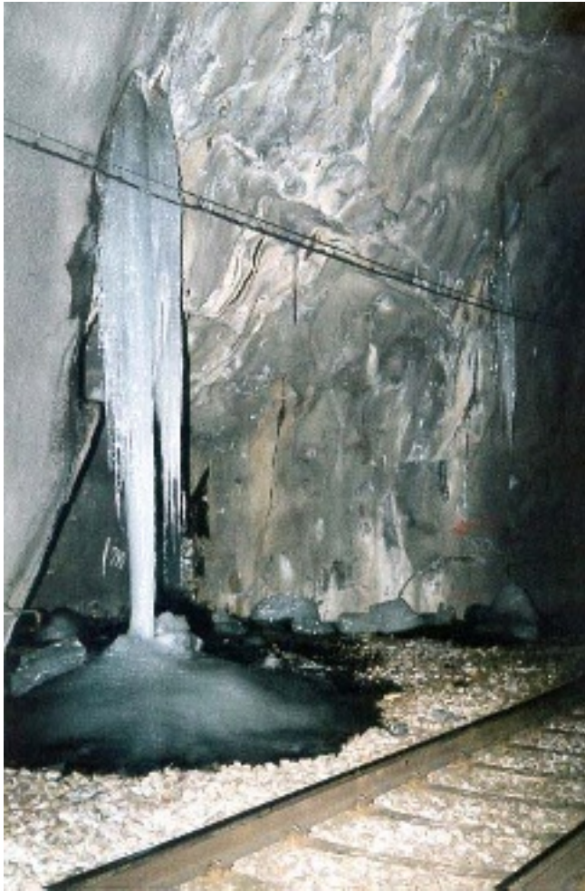
Figur 2.3.2.2 Is i Glödbergstunneln (Andrén 2006)
