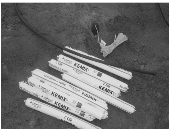
Figur 17. Kemix och elektronik kapslar samt laddning av salva 5.
