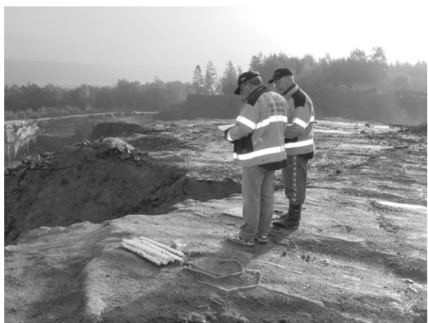
Figur 17. Kemix och elektronik kapslar samt laddning av salva 5.
