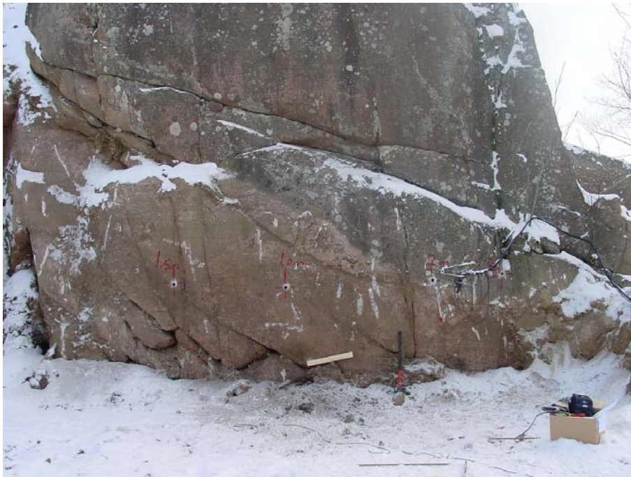
Figur 2-1 Granitväggen, försöksplats ett, med fyra spränghål \phi 38 mm som från vänster räknat har djupen 1,5 m, 1,0 m 2,0 m och 0,5 m.
