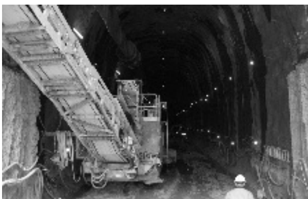
Figur 3.3 Bilden visar reflekterande mätpunkter vid uttag av centrumtunneln ( The picture shows reflected monitoring points in the pilartunnel )
