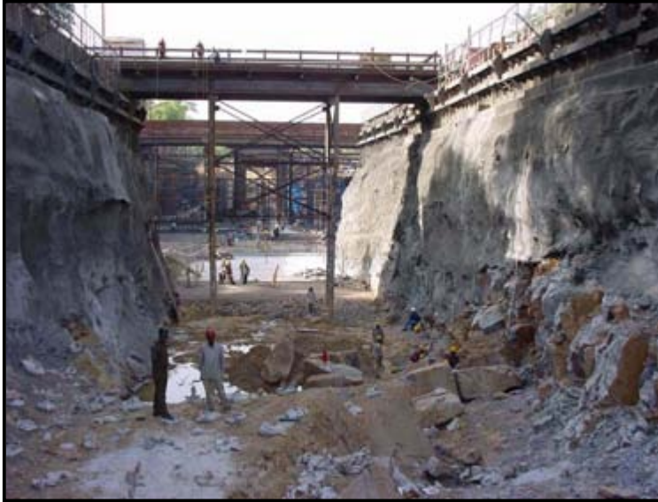
Figure 6 Blasted trench near A2 section Sprängt dike nära A2 sektionen
