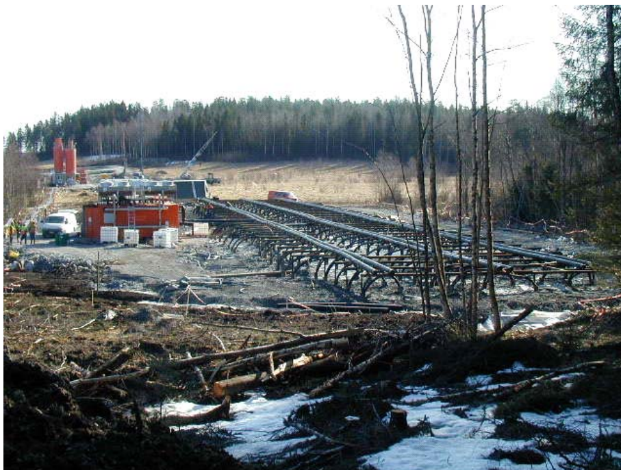
Fig. 3. Kylanläggning med matar- och returledningar (Foto Lemcon AB).
