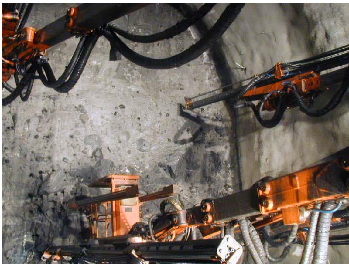
Fig. 7. Borring av salva inom det frysta partiet (Foto Lemcon AB).
