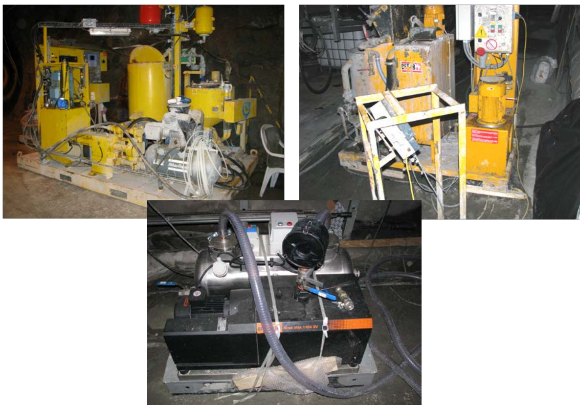
Figur 5. Bilder på några injekteringsutrustningar som använts för silica sol samt vakuumpumpen.
