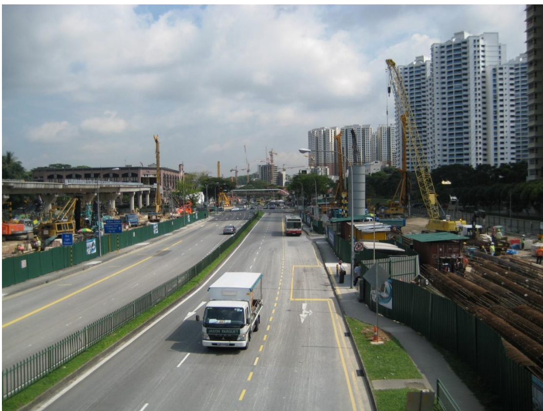
Figur 2: Pågående installation av temporära sekantpåleväggar för stationsdelen. Figure 2: Installation of the temporary secant pile walls.
