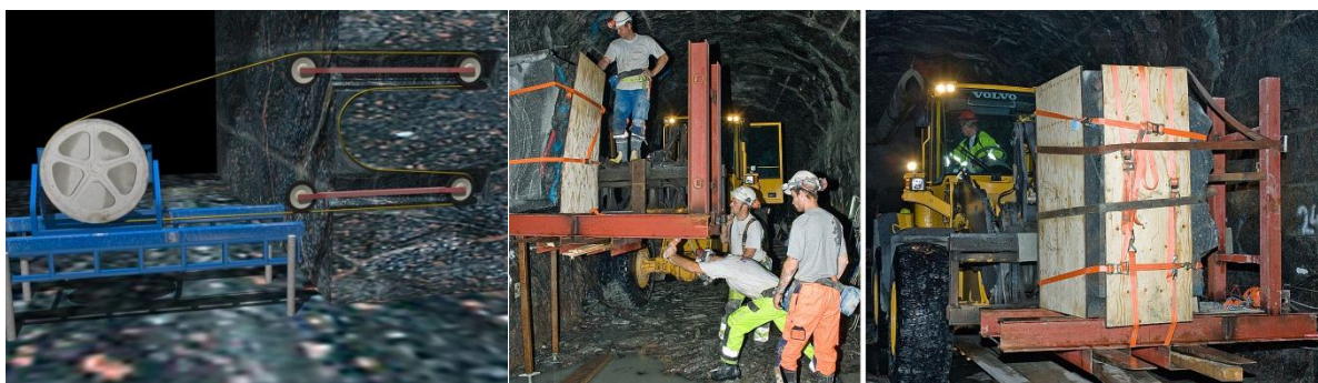
Figur 4. Wiresågning och blockuttag. Wire sawing and block excavation.
