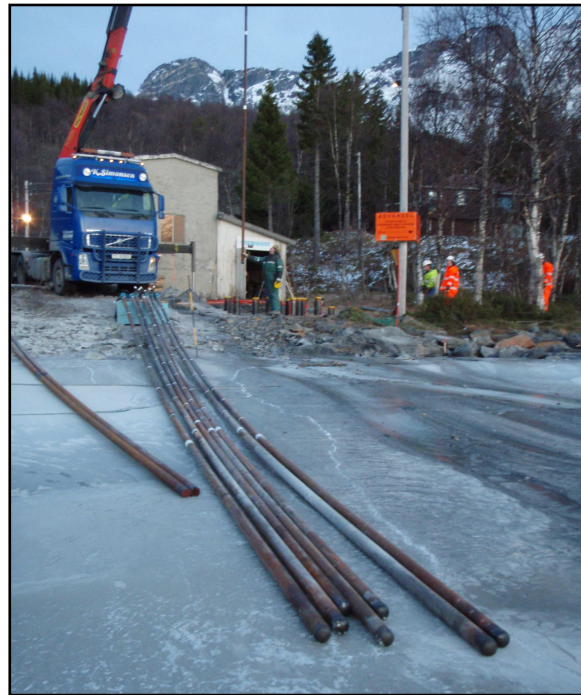
Figur 3: Venstre: Boring ned i vannfylt tunnel. Høyre: Fryserør klar for montering. Lukehuset sees i bakgrunnen.
