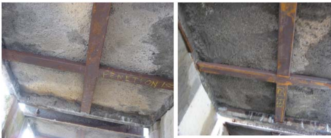
Figur 5. Undersidan på 150 mm Penetron Admix till vänster och referensprovet till höger efter avslutad test med 1 m vattenpelare
