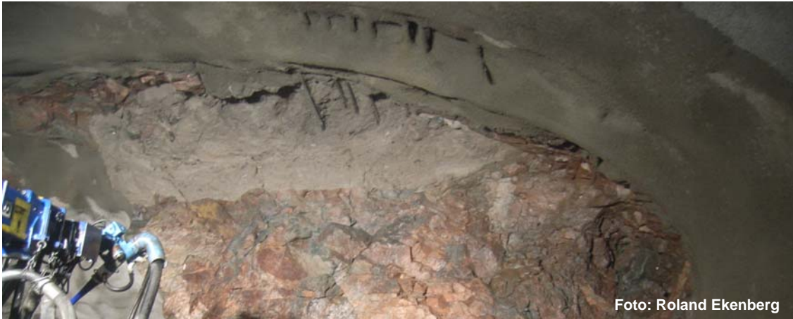
Figur 9. Insprutade gitterbågar, spiling och inträngning av morän i tunnelns hjässa Figure 9. Shotcreted lattice girders, spiling and intrusion of moraine in the roof of the tunnel
