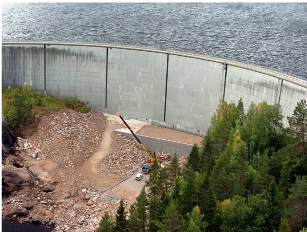
Figur 1: Översiktbild av Krokströmmens valvdamm (Foto: Fortum). Overview of the arch dam at Krokströmmen (Photo: Fortum).
