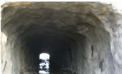
Figur 8. Ett av tunnelrören innan efterinjektering
