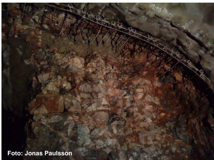
Figur 2. Bergmassan och inträngning av morän i tunnelns hjässa Figure 2. Rock mass and intrusion of moraine in the roof of the tunnel
