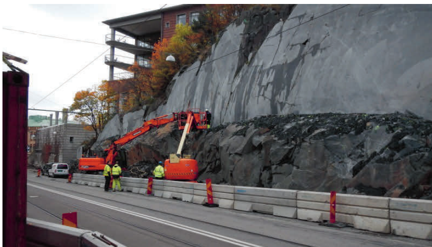
Figur 1 Bilden visar en bergslänt längs Aschebergsgatan i Göteborg som breddas. Fotograf Magnus Eriksson.
