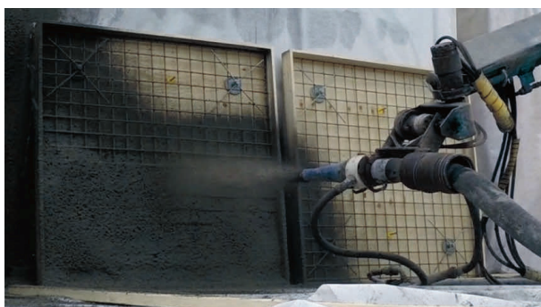
Figur 3: Sprutning av betongplattorna. (foto A. Andersson)
