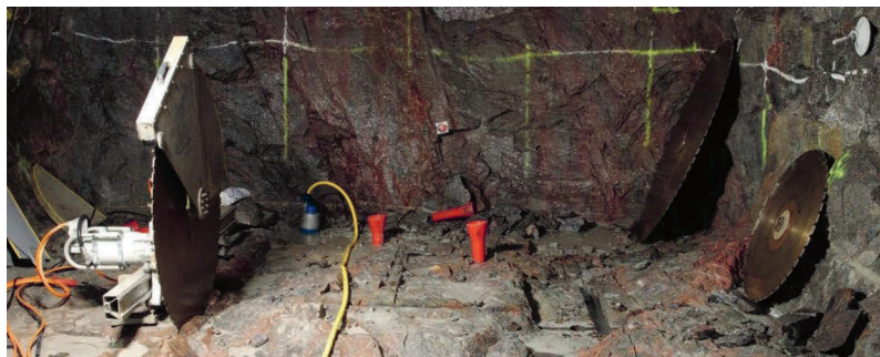
Figur 4 Pågående arbete med uttag av slits i sulan, sektion 34 m i TAS04. Ongoing sawing work in the floor of TAS04, section 34 m.
