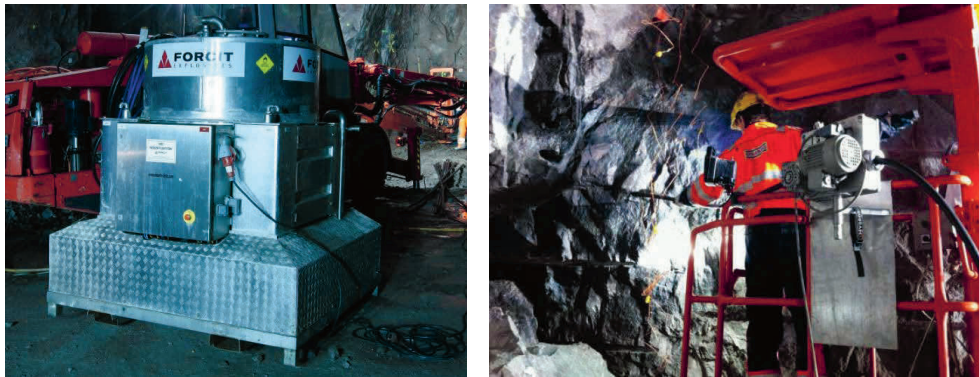
Figur 3 Forcit Laddenhet 201 och laddning med slangdragare i TASJ. Charging unit Forcit Laddenhet 201 and hose feeder in TASJ.
