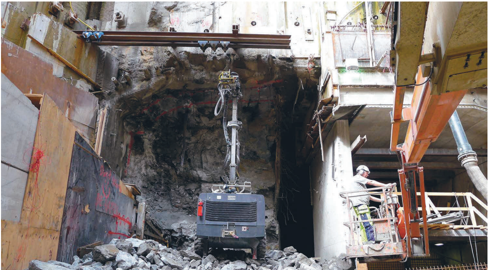
Figur 7: Berguttaget för den västra delen av spårtunneln påbörjat.
