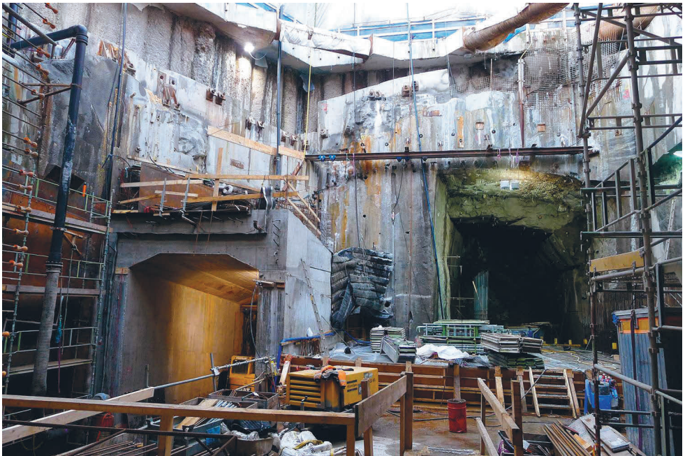
Figur 5: Den östra spårtunneln utsprängd och arbete med servicetunneln påbörjat. Observera den stöttande bergpelaren mellan spårtunnel och servicetunnel.
