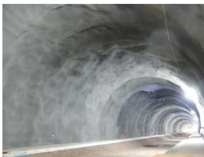
Figur 1. Ferdig bygd tunnelkledning med sprøytebetong og sprøytbar membran. Til venstre: Gevingåstunnelen, 1850 m tunnel av totalt 4200 m (2009). Til høyre: Holmestrandtunnelen, Snekestadsonen, 90 m tunnel av totalt ca 12 km (2015).
