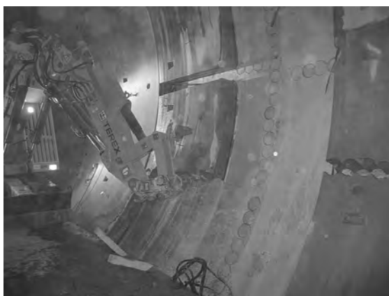
Figur 4.2 Bortlyftning av delat tunnelsegment inför start på ny tvärtunnel. (Removal of tunnel segment before start of excavation)
