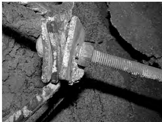
Figur 14 Glappande infästning Loose fixation
