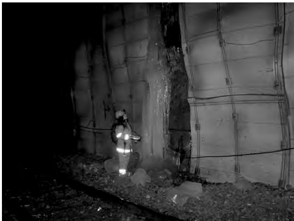
Figur 1 Isbildning mellan mattor av PE-skum i en järnvägstunnel. Ice formation between drainage system
