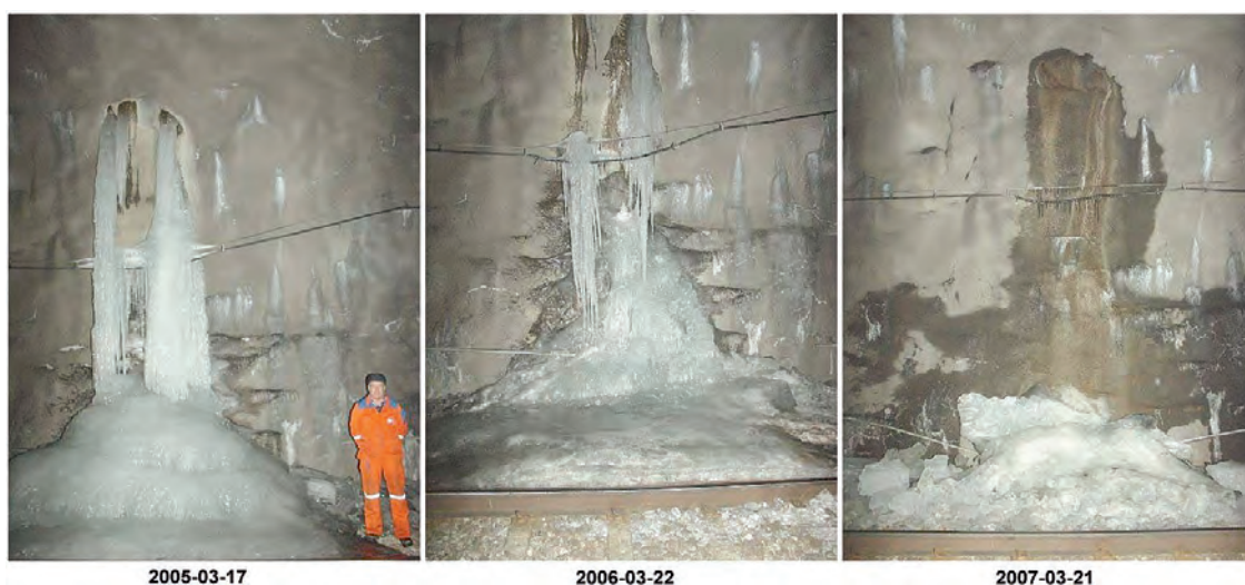
Figur 3-2 Jämförelse vid viss sektion i Glödberget vid samma tidpunkt på året under tre år – 2005, 2006 och 2007 (Andrén, 2008)
