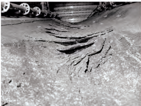
Figur 2. Illustration av spjälkprocessen i en överbelastad granitisk bergmassa.
