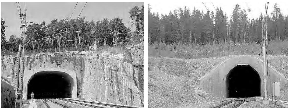
Figur 2.2 De södra mynningarna vid Åsatunneln respektive Glödbergstunneln (Andrén) The southern portal of the Åsa tunnel and the Glödberg tunnel (Andrén)
