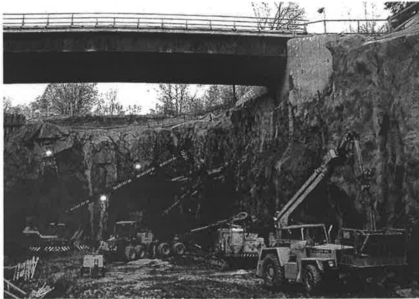
Figur 7. Foto visande borrarutrustning för borrhning av hål 10 m över schaktbotten. Figure 7. Photo showing drilling equipment.
