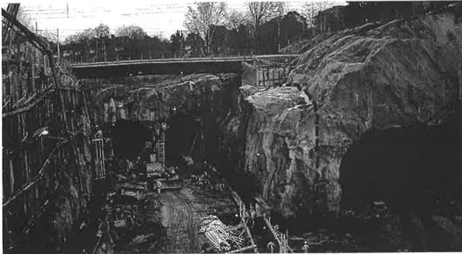
Figur 1. Foto av bergpelaren mellan bergtunnel 214 och ramperna 211 och 213. Figure 1. Photo of the pillar between the rock tunnel 214 and the ramps 211 and 213.
