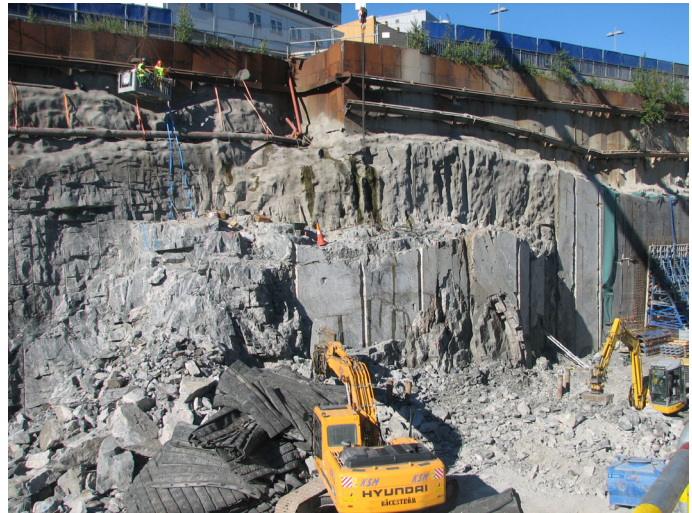
Figur 6. Illustration över geometriska förutsättningar (och last) samt fotografi på klack med en pall kvar att spränga.
