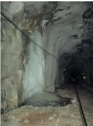
Figure 3.13 Ice layer in the Glödberget tunnel (Andrén, 2008).
