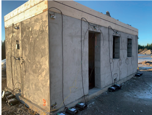
Figur 2.3 Foto av byggnad i försöksserie 2 med instrumentering. Från Remedy (2021). Photo of building in test series 2 with instrumentation. From Remedy (2021).
