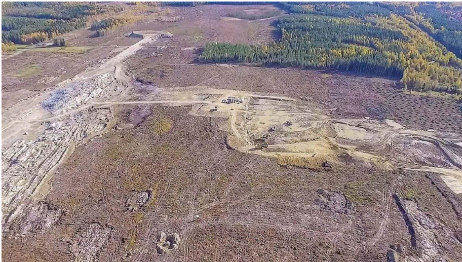
Figur 5.9 Påbörjat schaktarbete för planerad batterifabrik, Skellefteå. Pilotfall 5. ( www.skellefteå.se ).
