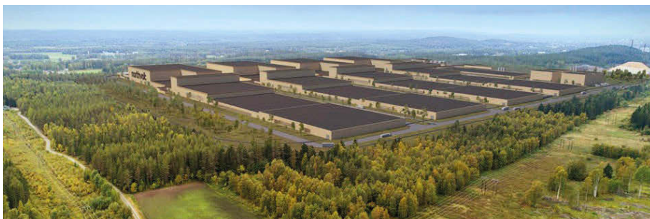
Figur 5.7 Illustration över planerad batterifabrik, Skellefteå. Pilotfall 5. ( www.skelleftea.se ).
