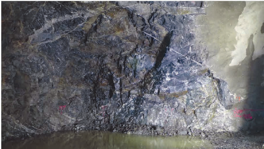
Foto 4. Östra (höger) vägg km 0/583-0/593
