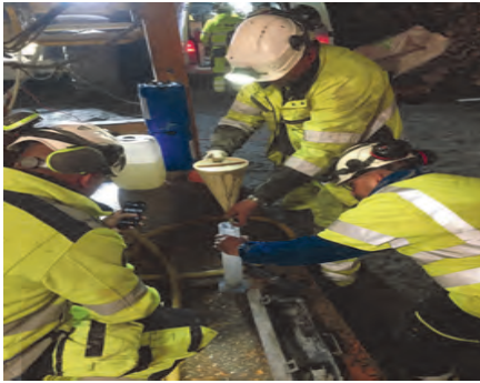
Figur 10.10. Kontroll av bruksegenskaper; Marshtid Figure 10.10. Check of grout characteristics; pump. Marsh time.
