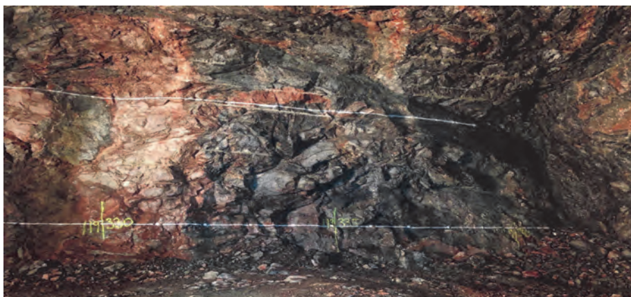
Figur 10.5. Grafitzon på vänster vägg, sektionerna. 119/330–340. Figure 10.5. Graphite zone on the left wall, the sections. 119/330–340.
