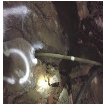
Figur 10.7. Kontroll av hålfyllning. Figure 10.7. Check of hole filling.
