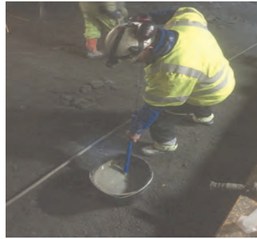
Figur 10.11. Kontroll av Filterpump Figure 10.11. Check of grout Filter
