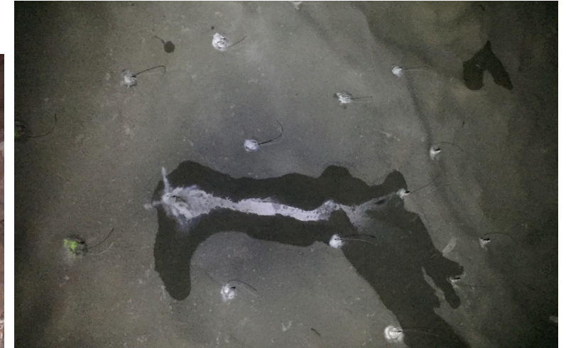
Utläckage av injekteringsbruk i bulthål, Sektion 119/280 (ca. 28 m från stuff)
