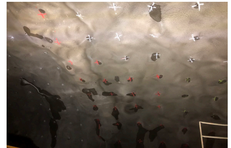
Utläckage av injekteringsbruk i bulthål, Sektion 119/280 (ca. 28 m från stuff)
