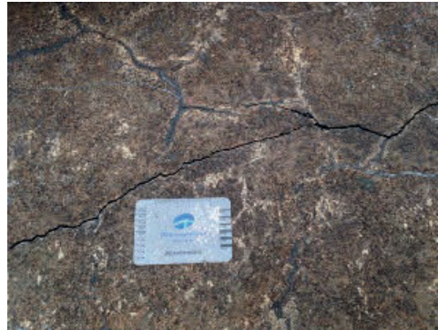
Figur 3.29 Mittbalkens övre yta.
