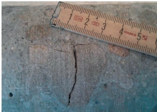
Figur 3.21 Borrkärna som visar större sten med spricka rakt igenom ballastkornet.
