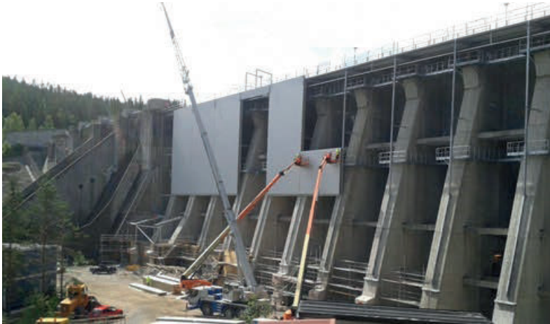
Figur 3.15 Montage av isoleringsvägg för att minska temperaturrörelser på lamelldamm.
