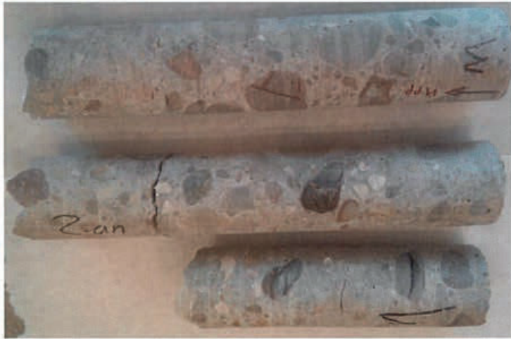
Figur 3.20 Borrkärnor från skadat utskovstorn, med sprickbildning kring och genom ballastkorn.
