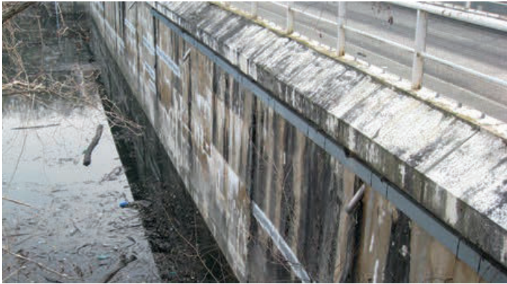
Figur 3.14 Försegling av grova sprickor med remsor av tätande material på betongdamm av massiv typ.
