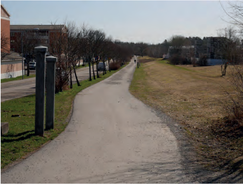
Figur 61. Vallen på gräsmattan längs Ullvidevägens sydsida. Ventilationsrör till den längs gångbanan förlagda fjärrvärmekulverten syns till vänster i bilden.
