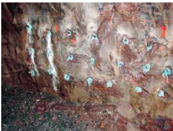
Figur 6. Bergbultar monterade i Äspötunneln
