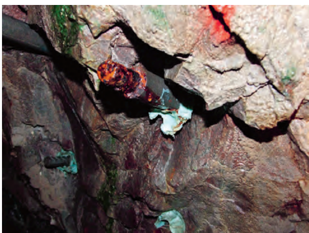
Figur 8. Delvis utdragen och ingjutna kolstålsbult efter åtta års exponering i Muskötunneln.
