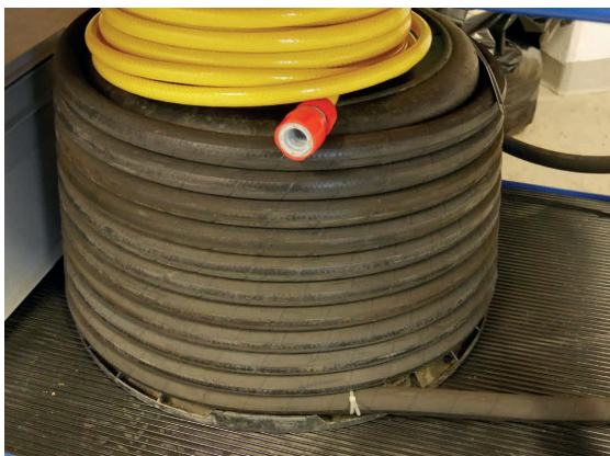
Figur 10. 20 m injekterings slang upprullad på en cylinder.
