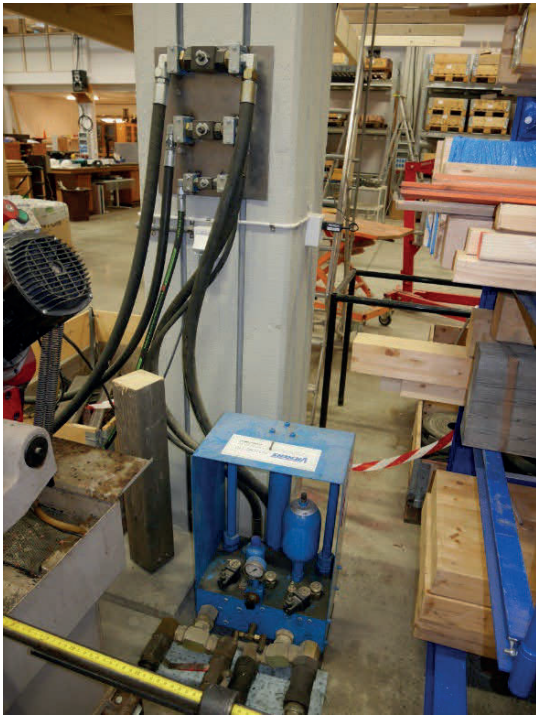
Figur 45. En av LTH:s hydraulstationer.
