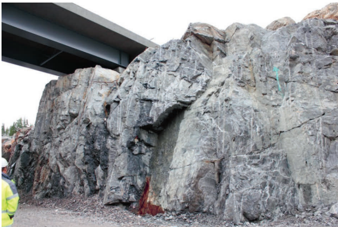
Figur 3. Bergschakt för bro. Blasting for a bridge
