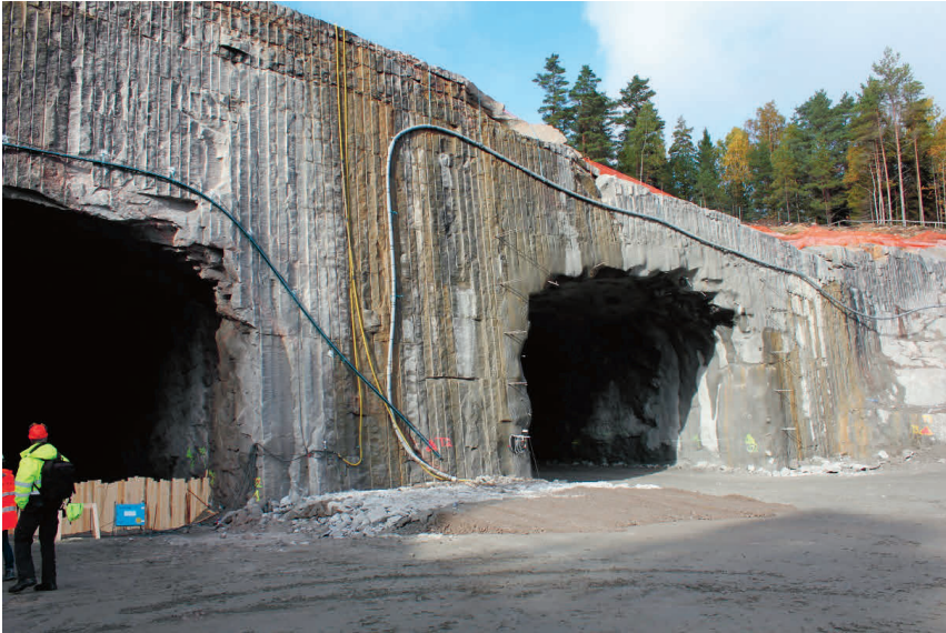
Figur 2. Tunnelpåslag med tätt hålmönster. Slope blasting with narrow spacing
