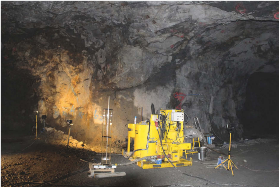
Figur 14:Plats G4. Sprickor markerade med blå färg syns i tunnelväggen till vänster och borrhål G4 under transmissivitetmätningar syns i tunnelväggen till höger.
