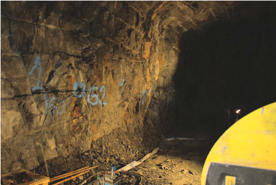
Figur 10: Borrhål G2 under transmissivitetsmätningar.
