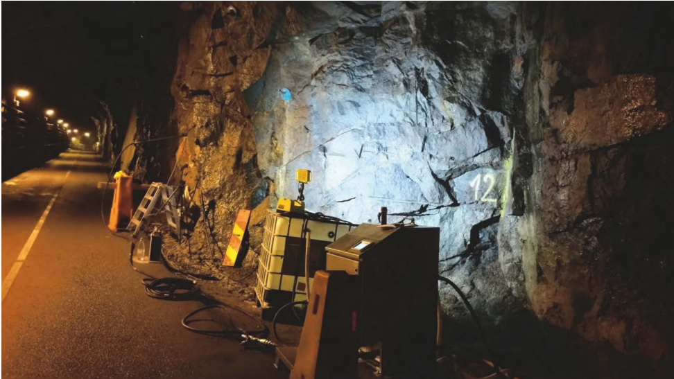
Figur 1: Plats under transmissivitetmätningar av BH12. Spricka 12 syns till höger i bilden.
