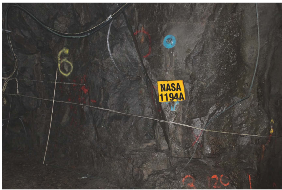
Figur 3: Spricka 6 vid måttstocken och ännu en spricka ca. 2 m till höger av spricka 6.
