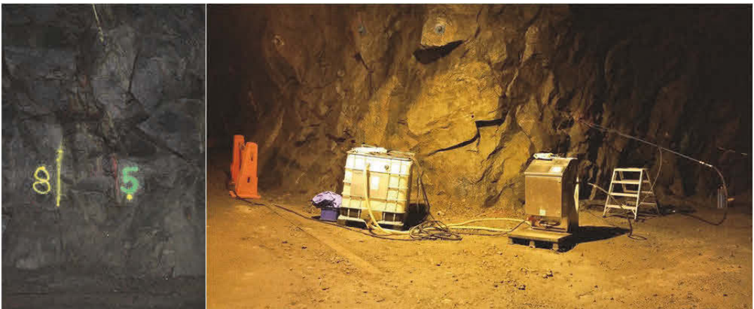
Figur 22: Transmissivitetmätningar av borrhål BH58 med SKBs High water injection controller (HWIC). Sprickor 5 och 8 som visas i den vänstra bilden finns i tunnelväggen nära de orange konerna.
