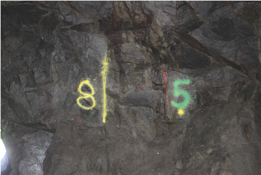
Figur 3: En närmare bild på sprickor 5 och 8.
