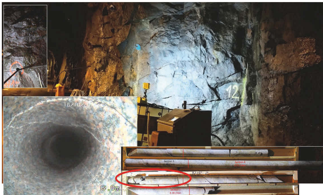
Figur 23: Transmissivitetmätningar av borrhål BH12. Bilden från borrhålkameran är från sektion 4. Bilden av borrhålkärna av sektioner 3,4 och 5. Våt tunnelvägg från vattendroppar från 1 m ovanför borrhålmyningen under transmissivitetstester av sektion 4 visas på bilden i den vänstra högerhörnan.
