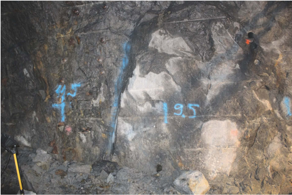
Figur 4: En tydlig spricka på plats G0 ca 10 m från korsningen.
