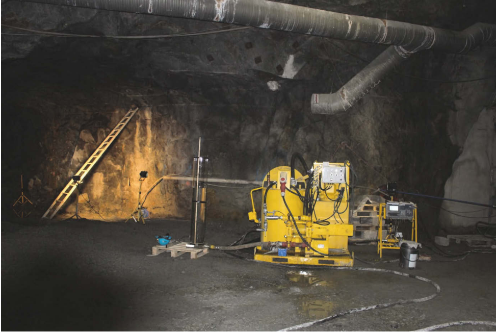
Figur 1: Unigrout med cylinder på plats G0. Injekteringsrör och slang syns i borrhålet under transmissivitetmätningen.
