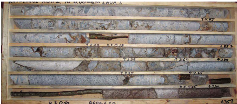
Figur 6-12 Borrkärnor från zonen mellan berg och betong. Rock cores from the zone between concrete and rock.
