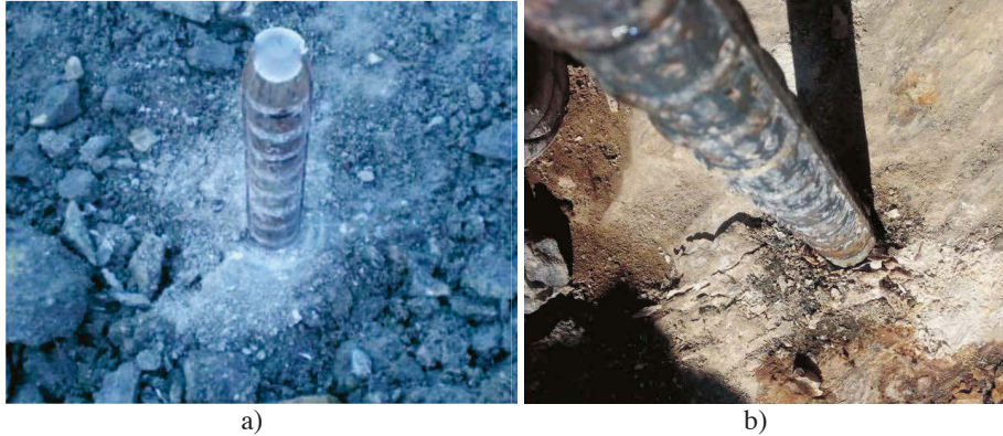
Figur 2-2 Foton på bergbultar från fältförsök, a) efter stålbrött. Från (Larsson 2008), b) efter krossning av berg. Från (Malm m fl. 2017) Photos of tested rock bolts, a) bolt after failure. From (Larsson 2008), b) bolt after crushing of rock. From (Malm et.al. 2017).
