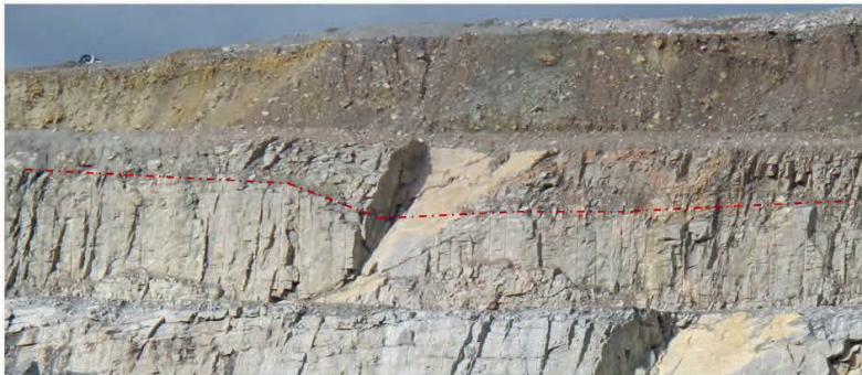
Figur 2-9. Ungefärlig utbredning av ytuppsprucket berg över streckad röd linje. Del av översta pallen i Aitiks dagbrott. Jordlagret är knappt 10 m och första pallen ca 15 m hög. (Foto: R. Christiansson).
