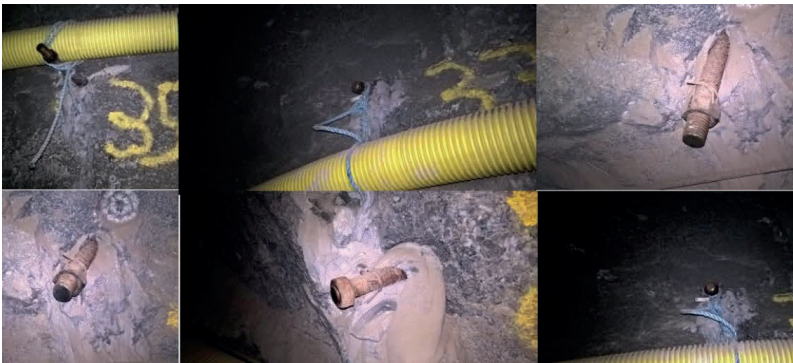
Figur 22 Bergbultar monterade vid teststationen Citybanan. Sammanlagt 22 bergbultar med olika längd, defekter och ingjutningskvalitet är monterade och samtliga undersöktes vid fältförsöken.
