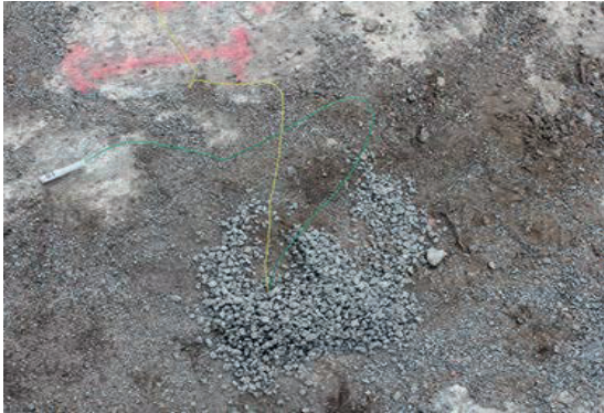
Figur 16. Proppat hål. Stemming of a hole
