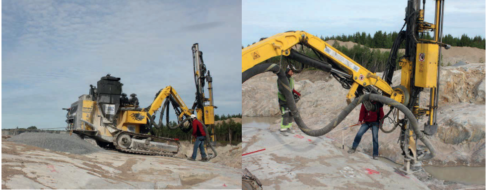
Figur 11. Borrning av försökshål. Drilling of the test holes
