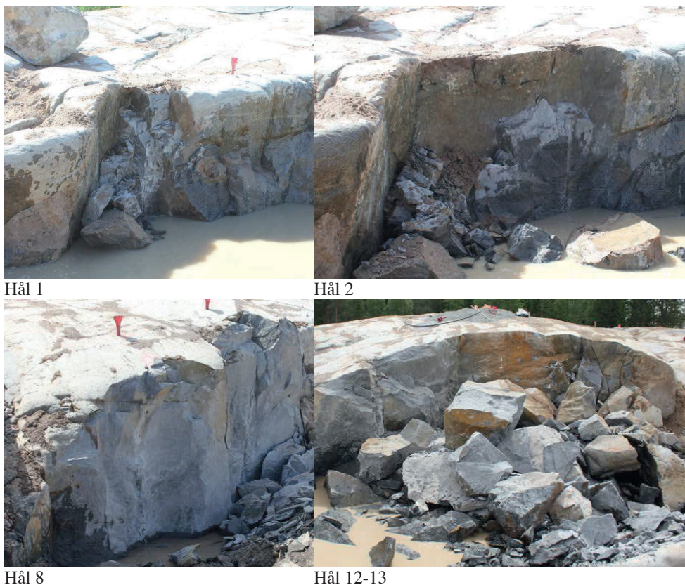
Figur 20. Resultat från sprängning av håll 1, 2, 8, 12 och håll 13. Blasting result from some of the holes
