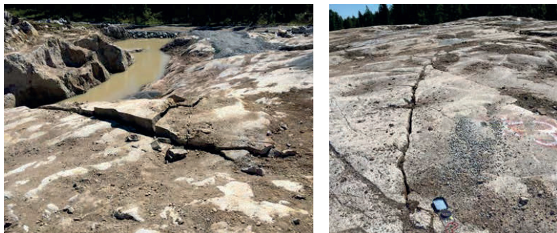
Figur 34. Sprickor där rörelser skett i samband med inspänd sprängning. Fractures opened up due to blasting
