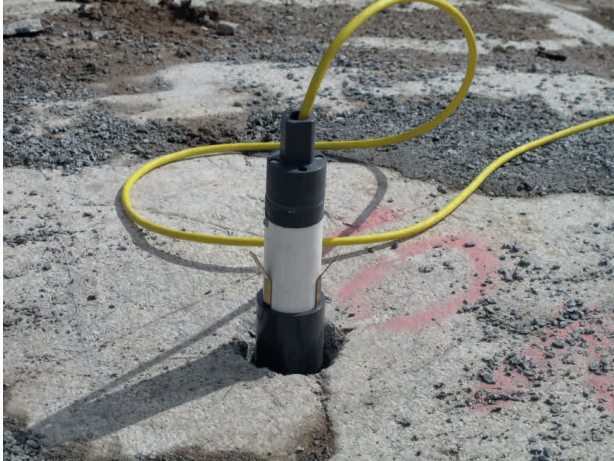
Figur 10. Installation av en geofon i ett mätthål. Installation of a geophone in a hole
