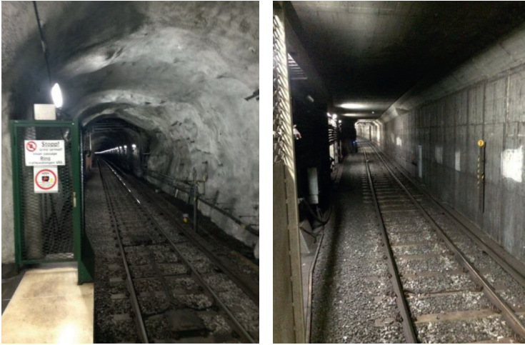
Figur 4 vänster bergtunnel inklädd i sprutbetong och till höger en betongtunnel. /left shows a rock tunnel with shotcrete and to the right a concrete tunnel.
