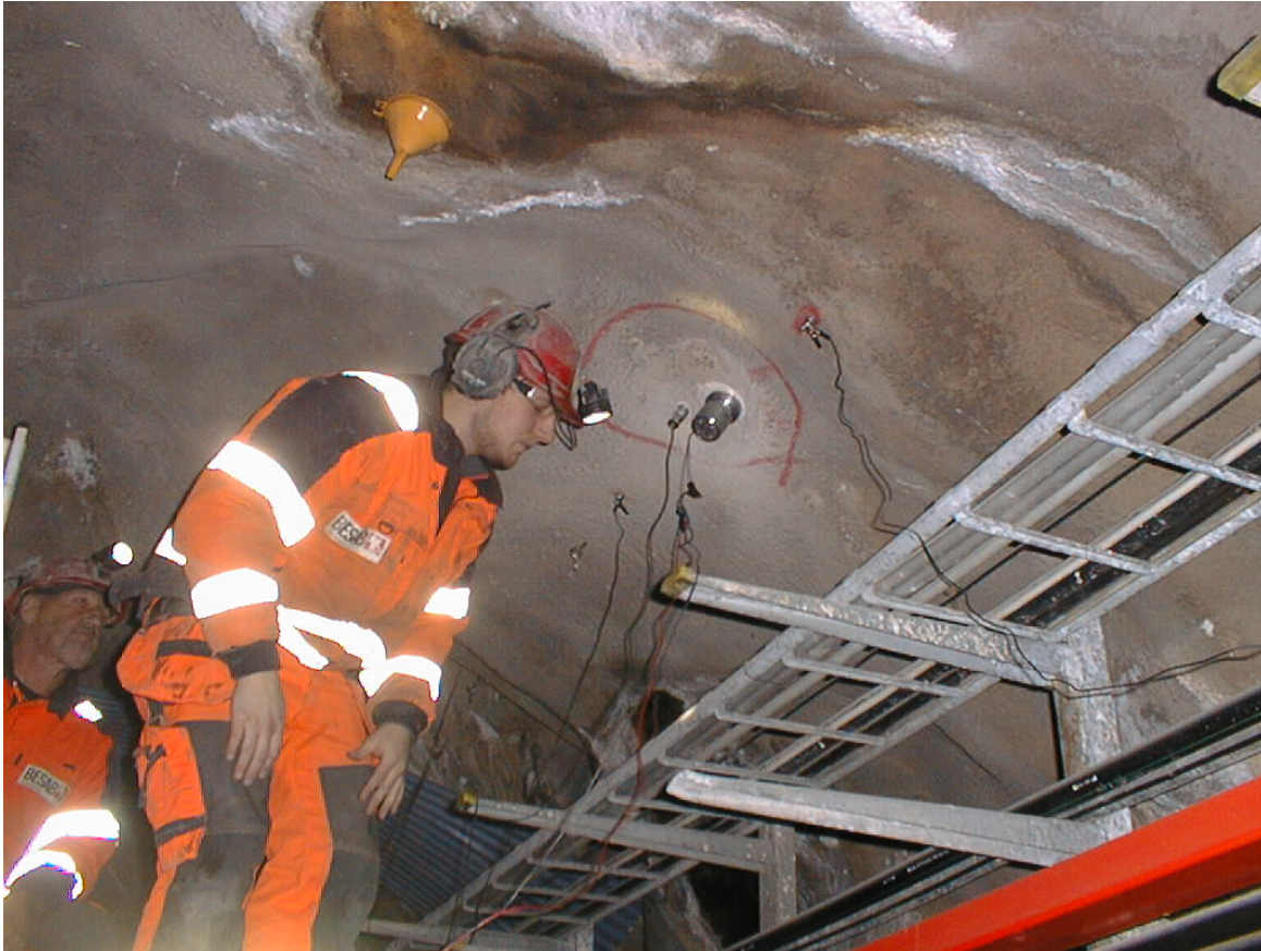
Förberedelser för mätning i tunnel
