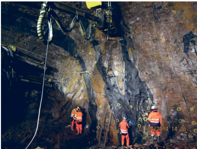
Figur 2. Bild på tunnelfront där en amfibolit (svart) syns i den röda graniten.
