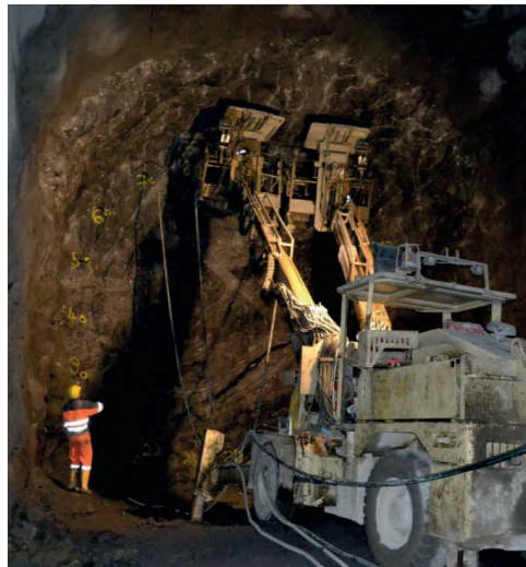
Figur 3-3 Injekteringsutförande, 3 man och två korgar vid skärm 31+956. (Grouting works at fan 31+956)
