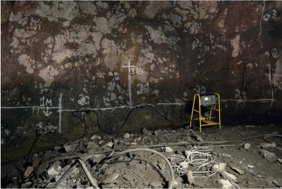
Figur 3-13 Injekteringsutförande hål 19 - 22 som injekteras samtidigt med en pump, på bilden ses också den Logac enhet som mäter trycket efter sista hålet (Multi-grouting of holes 19 – 22).
