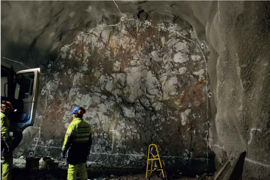
Figur 3-12 Förberedelser vid stuff Kvarnholmsförbindelsen (Grouting fan preparations at Kvarnholmsförbindelsen)
