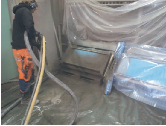
Figure 3.13. Spraying of test slabs. Sprutning av provplatta.
