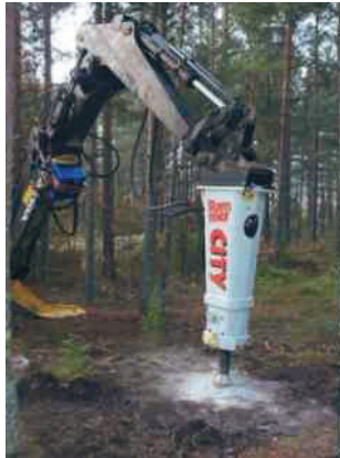
Figur 4. Styrbar bilningshammare använd vid SIST-mätningar Hydraulic hammer used in SIST-measurements
