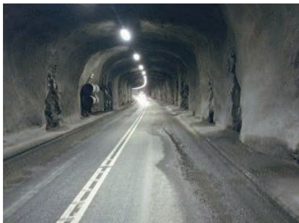
Figur 1 Muskötunneln ( The Muskö tunnel ).
