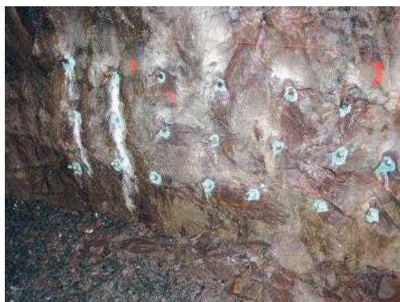
Figur 6 Bergbultar monterade i Äspötunneln (Rock bolts mounted in the Äspö tunnel)
