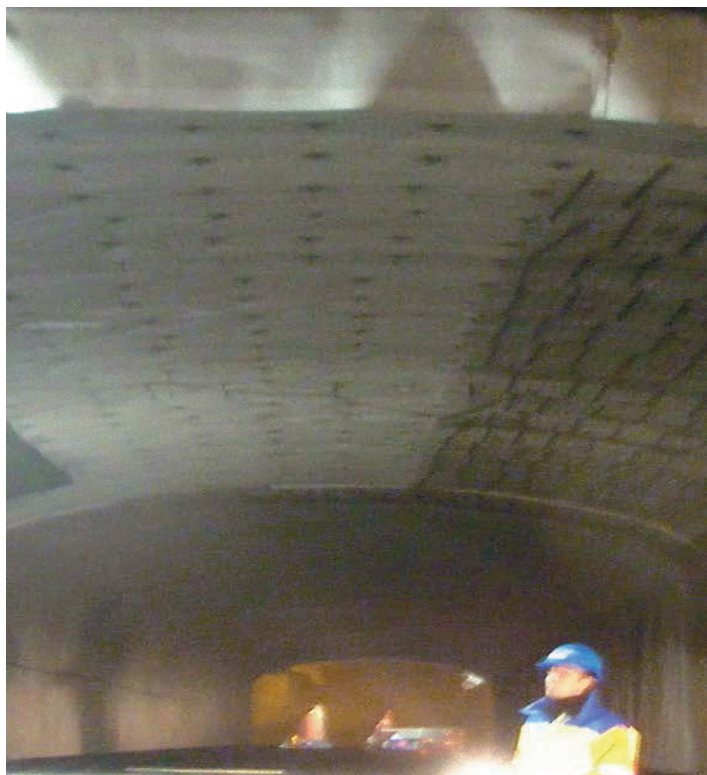
Figur 12. Inklädnad i Norra Länken. Membranet täcks senare med 100 mm fiberarmerad sprutbetong.
