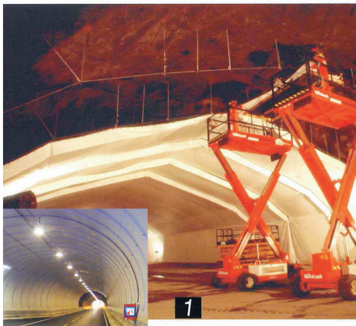
Figur 11. Montering av membraninklädnad, typ tunnelduk.
