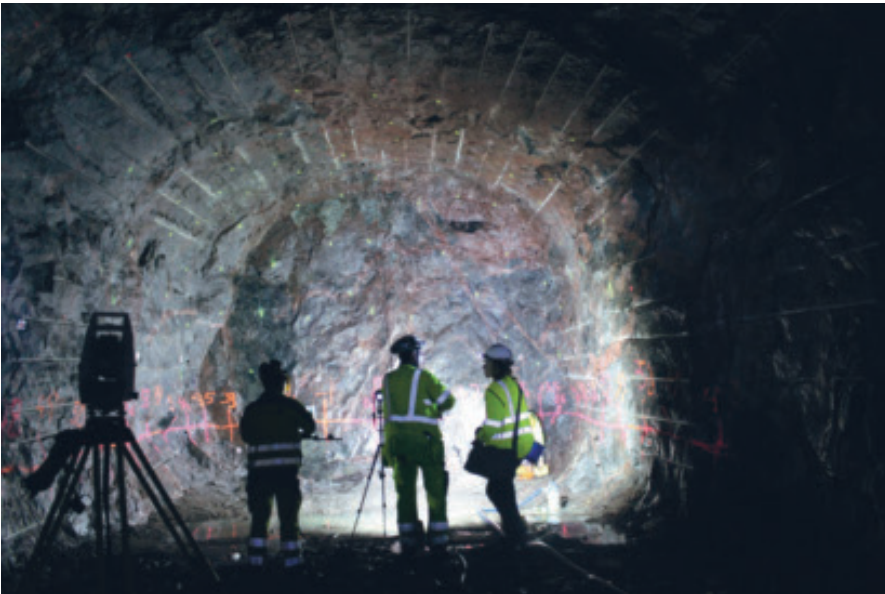
Figur 37. Tunnelkontur i utbyggnaden av Äspölaboratoriet. Tunnel contour blasted with string emulsion at Äspö (Foto EDZ-Consulting)
