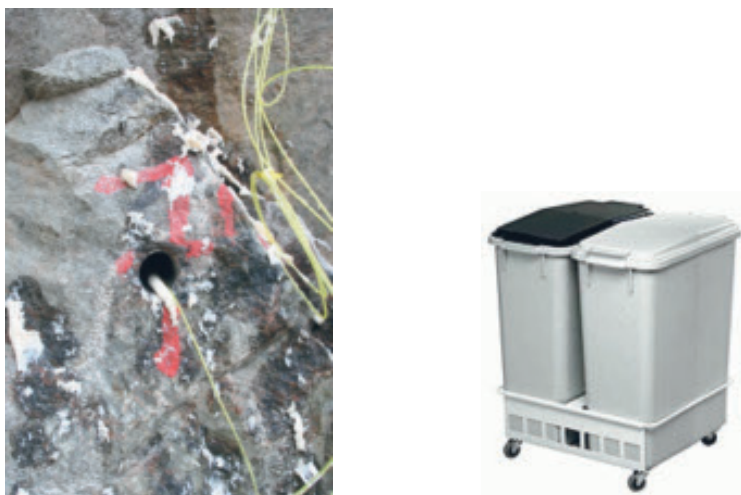
Figur 32. Spill från pumpemulsionsladdning och exempel på uppsamlingskärl. Spillage from pump emulsion and spillage containers (Foto EDZ-Consulting)
