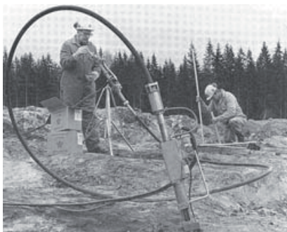
Figur1. Laddning av Dynamex med pneumatisk laddapparat (Olofsson). Old charging method.
