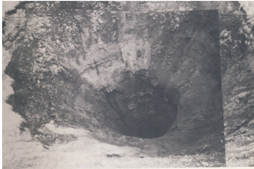
Figur 15: Krater orsakad med raset i Gidböle tunneln (Från Hultman et al. 1993).
