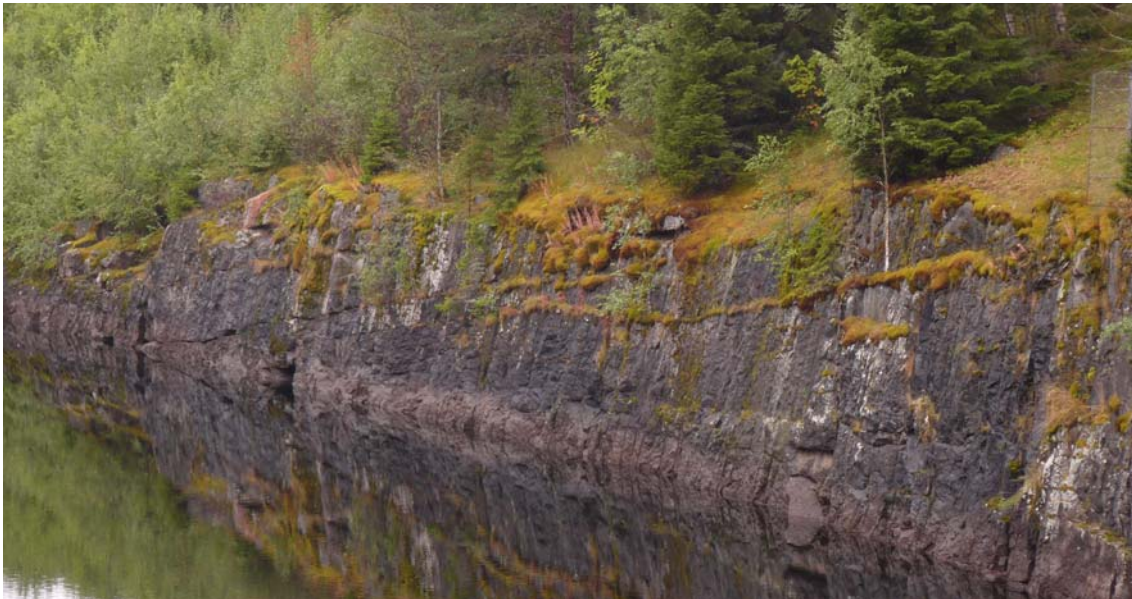
Figur 3.1 Foto som visar förekomsten av flacka sprickplan i utloppskanalen vid Långbjörns kraftstation. Photo of persistent relaxation joints in the tailrace channel at Långbjörn hydropower station.
