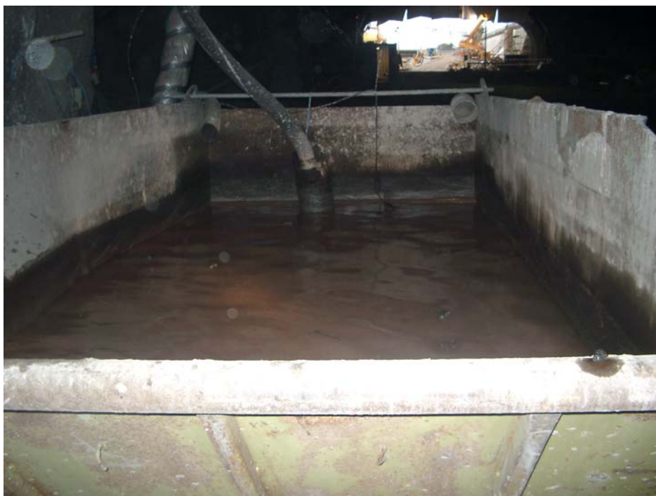
Figur 4.2. Länshållningsvatten som pumpas till container för slamavskiljning i Törnskogstunneln (Norrortsleden) i Sollentuna (foto Johan Ekvall)
