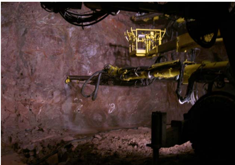
Figur 2.1. Borrrigg i arbete med Norrortsleden i Sollentuna (foto Gunnar Borg)
