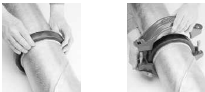
Fig 2-1. Skarv på Alveniusrör
