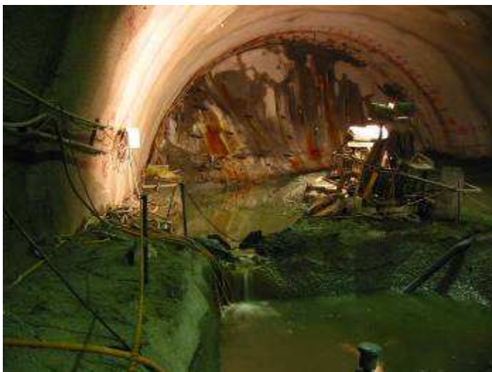
Figur 3-2. Flödesmätning med hjälp av V-format överfall vid tunnelbrytning för höghastighetståg i Taiwan.
